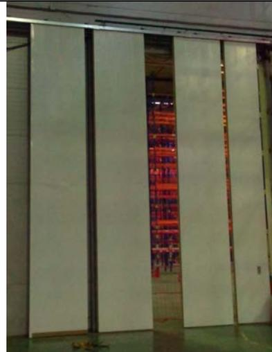
Состыковываем панели и стягиваем их в двух местах.
